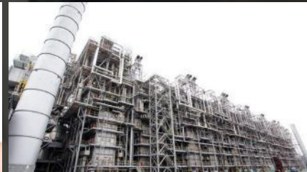
석유화학 Plant 단열재
